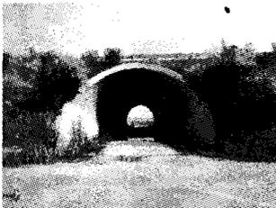
图1a 圆形波形钢板
